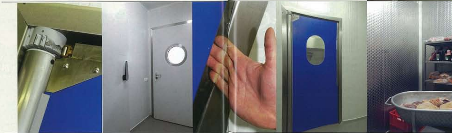
HOSA INSTALLEERDE IN HET ATELIER VAN SLAGERIJ CAUWELIER ALLE DEUREN, WANDEN EN DE BEKLEDING VAN DE KOEL- EN DIEPVRIESRUIMTES.
